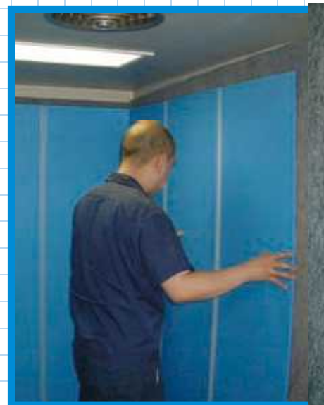
③倒れない様に養生テープで押さえる
